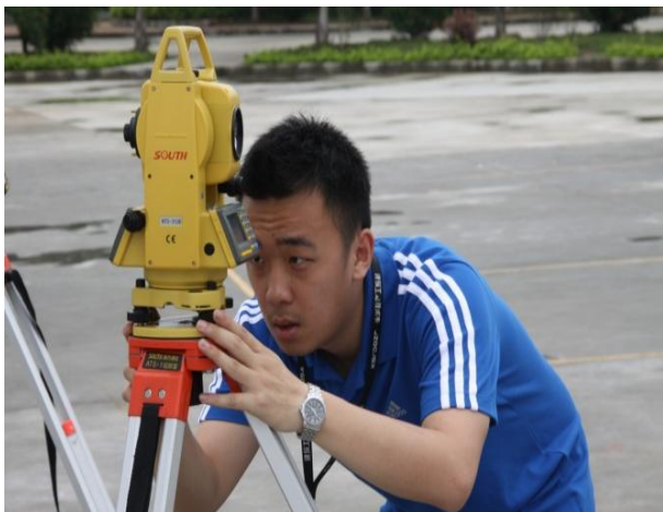
学生在现场开展测量工作
